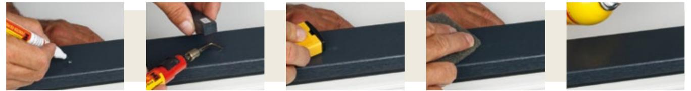
**Anwendungsbeispiel:** Schadstelle im Fenster-Profil mit dem Fenster-Fix PREMIUM vorfärben. Dann das Hartwachs PLUS schmelzen und in die Schadstelle einbringen. Überschüssiges Wachs mit dem Füllstoff-Hobel oder Kombi-Hobel abtragen und die Stelle mit dem Vlies entfetten. Am Ende mit dem Sprüh-König® Klarlack PLUS den Glanzgrad anpassen und gleichzeitig die reparierte Stelle versiegeln.
